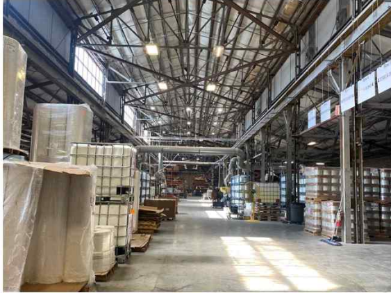
그림 3. 제조 시설 내 자재 보관. 원자재가 준비되어 있는 동안 근처에서 부품의 압출 성형 라인이 설치되고 있다. 출처 | CW
